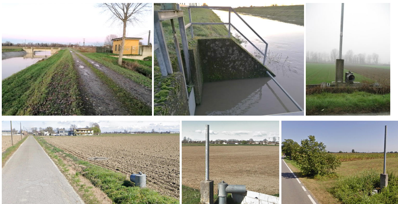
Figura 1: rete irrigua con condotte in pressione interrato. Planimetria in scala 1:25.000 ridisegnata dagli shape file forniti dal Consorzio Muzza. Nelle foto l'impianto di sollevamento visto da SW, il punto di presa sull'allacciante visto da valle e dissipatori idraulici della rete in pressione con idranti che scaricano nella rete di adacquatrici.
