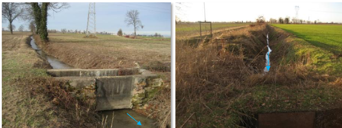
Figura 5: Roggia Bossina in corrispondenza del sovrappasso del ramo orientale della roggia Molina Pozzo (Molina AA SE064AA), a destra poco a monte dello scarico nella Roggia Molina B (Cod SE64B).
