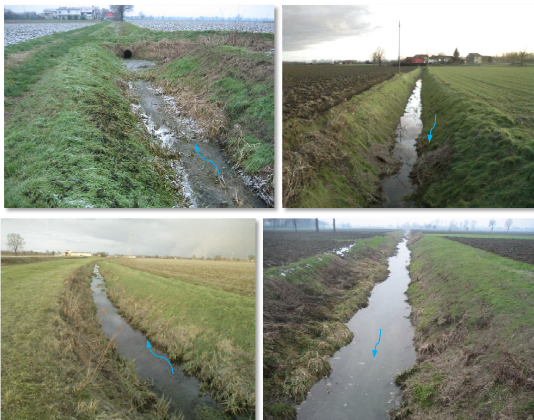
Figura 23: sequenza di riprese: 550 m a monte del passaggio sotto la SP 116, dalla località Quartierone verso monte e verso valle, e dal ponte della SP 195, già fuori territorio comunale, verso monte.
