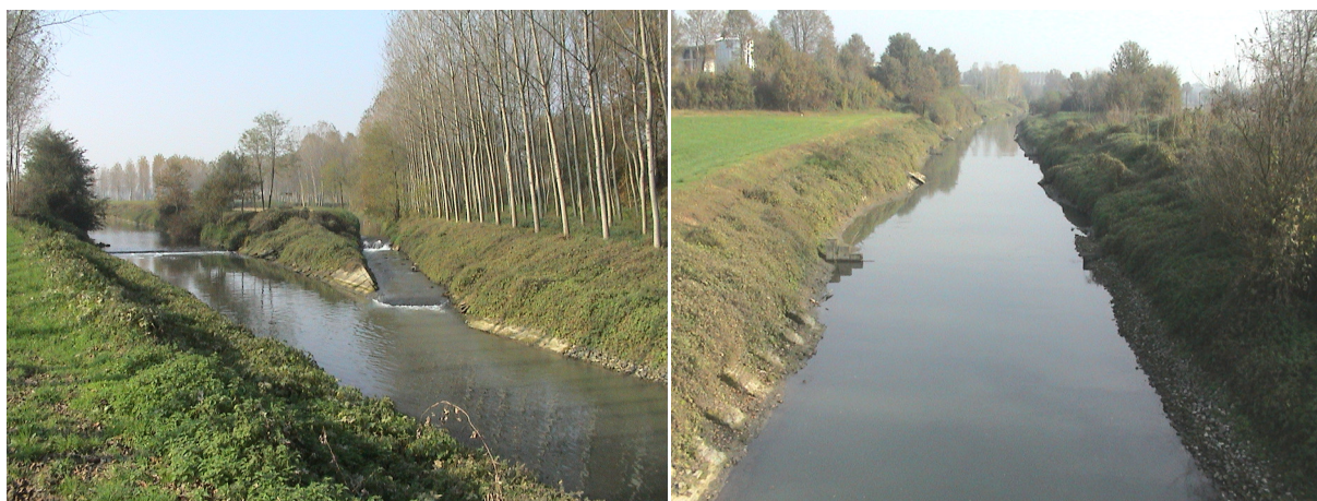
Figura 2 Scarico della Roggia Guardalobbia nel Canale Gandiolo e a destra Il Canale Gandiolo a valle del ponte del Fornasotto.
