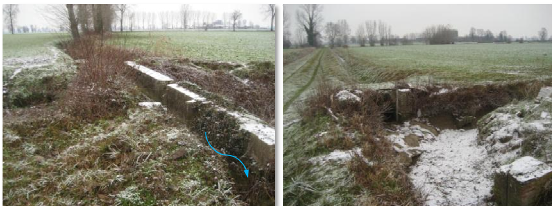
Figura 11: ponte canale sopra il colatore Guardalobbia e manufatti in parzialmente crollati 590 m a valle dell’ingresso in territorio comunale .
