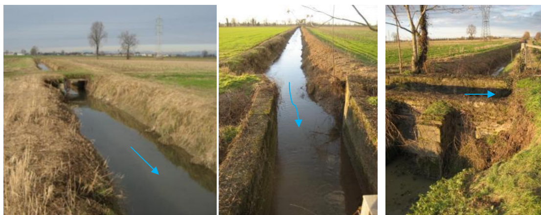
Figura 3: tratto al confine a NE, e a destra il passaggio sopra il ramo orientale della roggia Molina B (SE064B)
