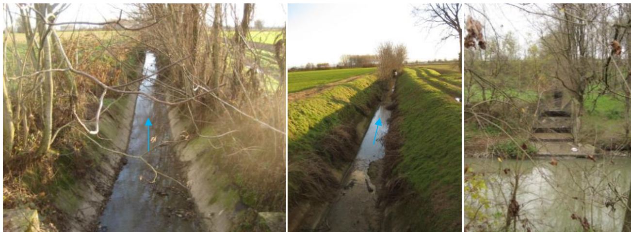
Figura 4: Scaricatore Maleo all'ingresso in territorio comunale, 200 m più a sud, e allo scarico nel Canale Gandiolo.
