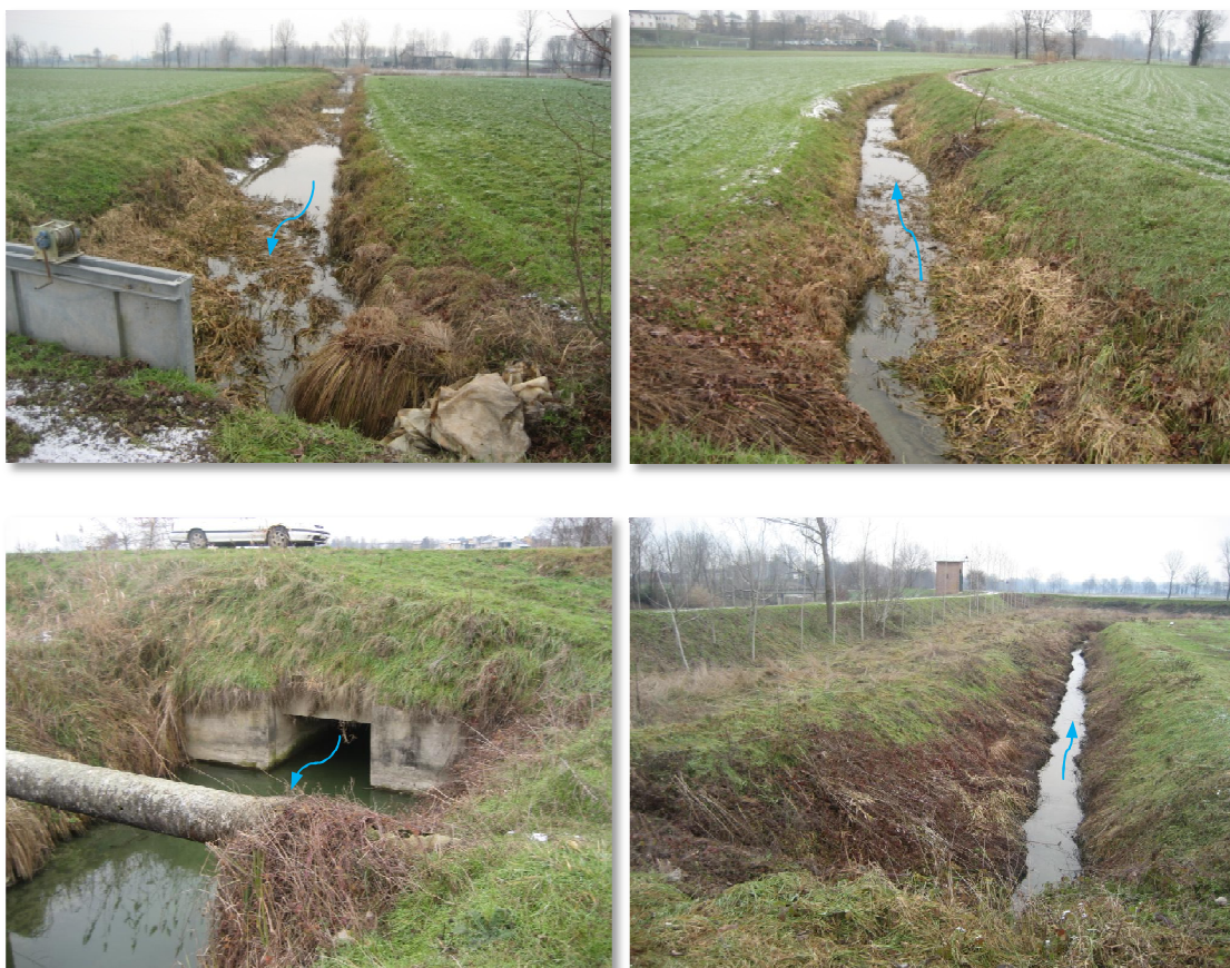
Figura 20: Fornasotto a monte e a valle del ponticello sulla carrabile per C.na Bianca, in uscita dal sifone sotto il Collettore Primario di Bonifica e immediatamente nel tratto a valle dello stesso
