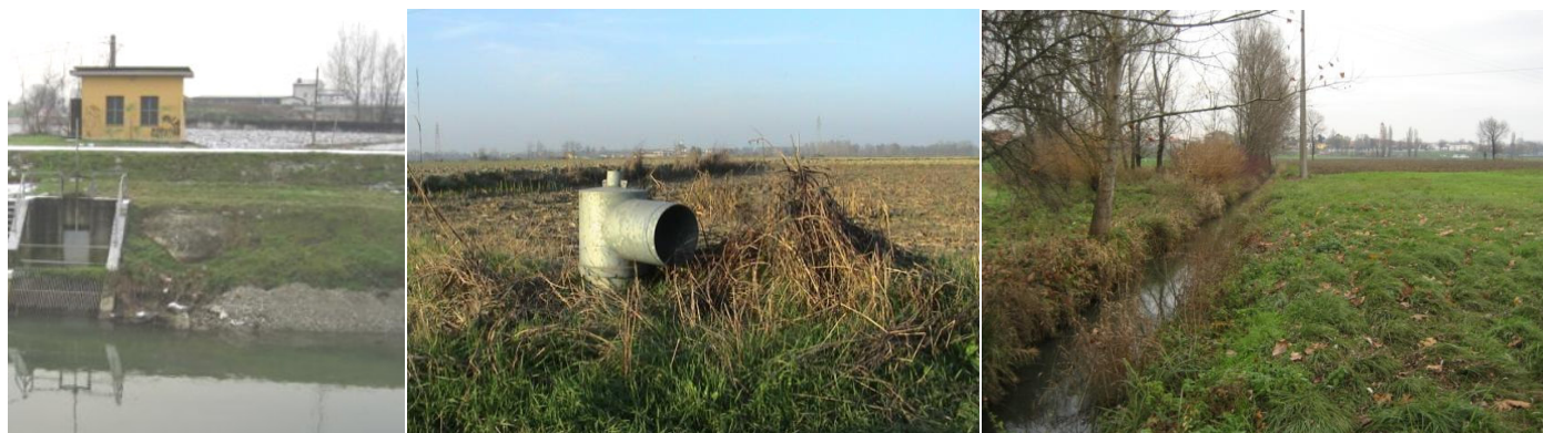
Figura 13 impianto di sollevamento e manufatto di irrigazione alimentato dalla rete in pressione. A destra colatore Gandiolo a valle della Cascina Mizzi.
