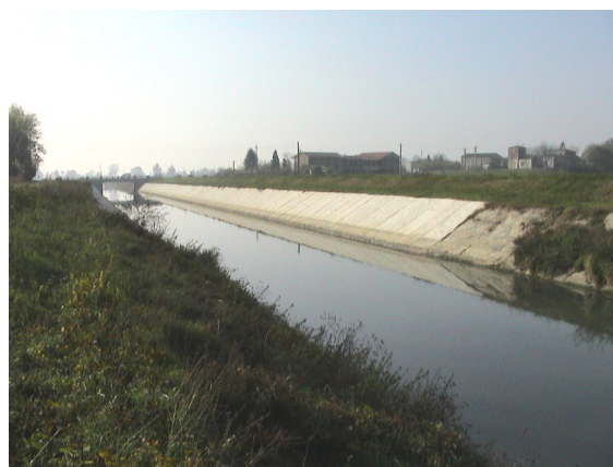
Figura 17 Canale Allacciante nel tratto SW, a monte del ponte del Mezzano
