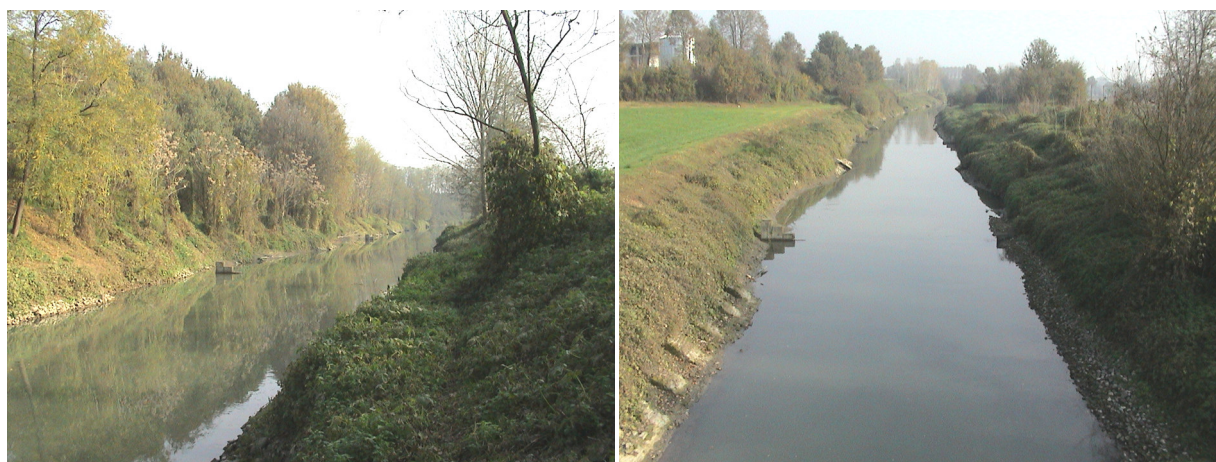
Figura 18 Canale Gandiolo a valle del ponte del Fornasotto
